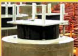
中国汕头的液化天然气储存槽工程
